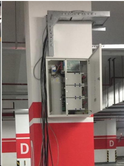
安装位置与照明桥架位置重叠，线路复杂
