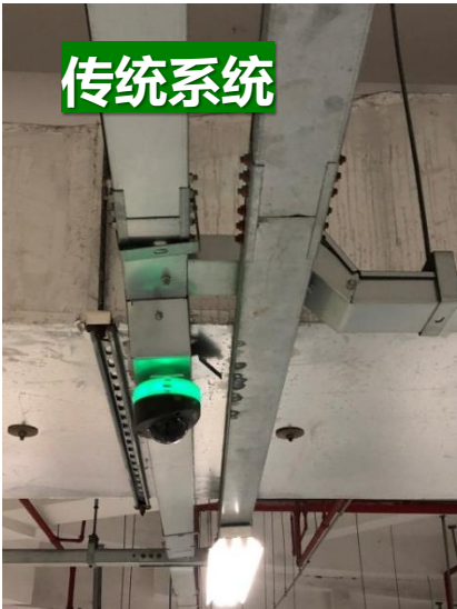
安装位置与照明桥架位置重叠，线路复杂
